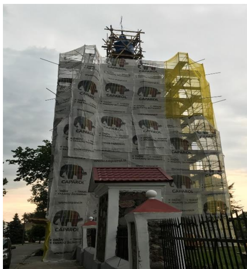
Dar vyksta darbai
