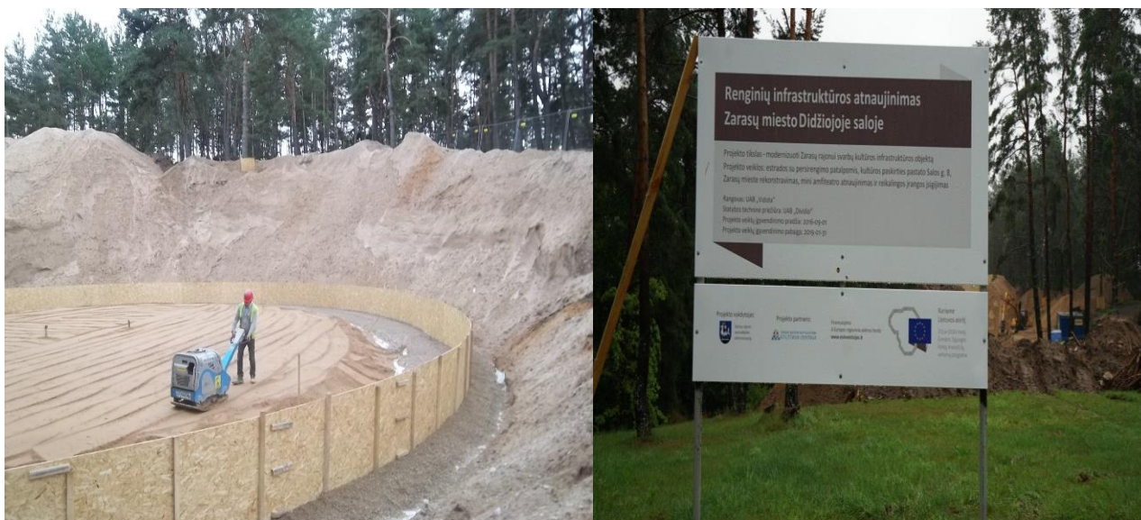
Pradėti estrados su persirengimo patalpomis pastato statybos darbai
